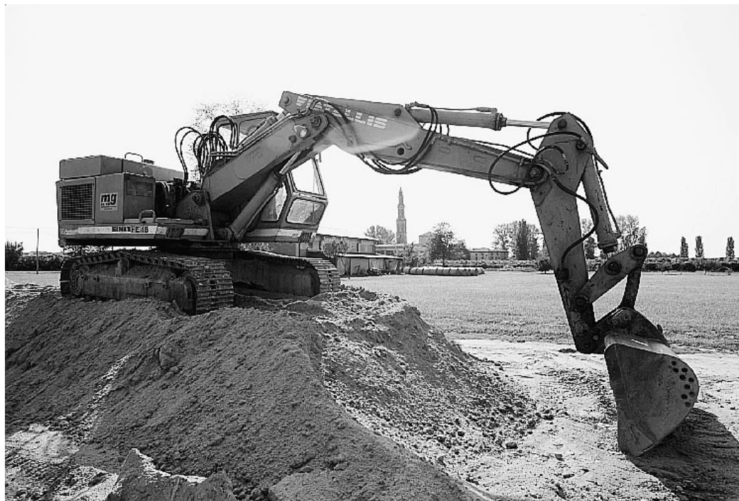
L'escavatrice con le montagnole di terra per la futura pista ciclabile; a sinistra gli Amici di Beppe Grillo
