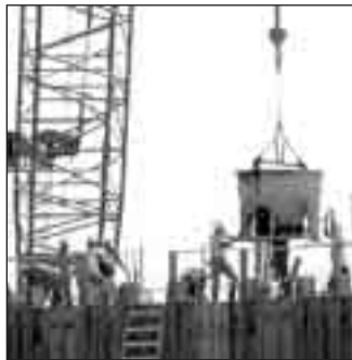
Lavori in un cantiere
